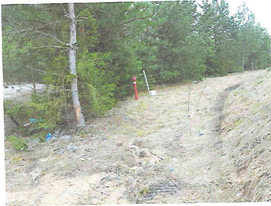
Fot. 5. Usytuowanie hydrantu zewnętrznego nadziemnego
