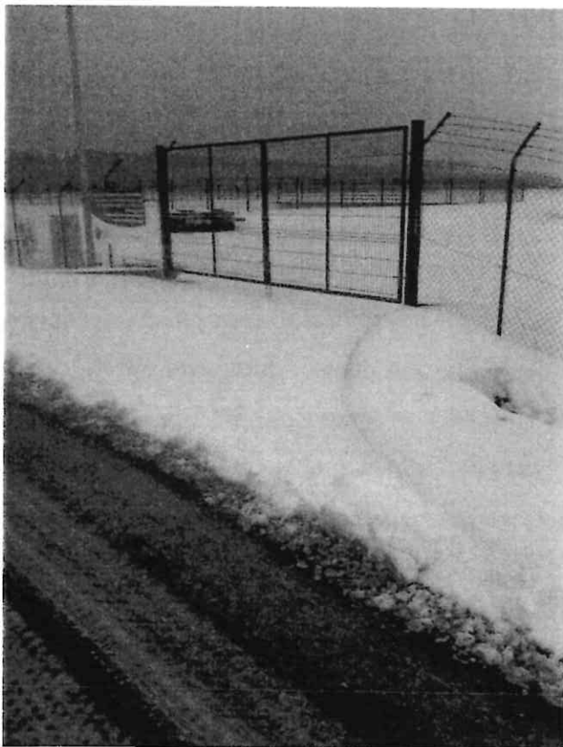
Zdjęcie nr 5. Brama wjazdowa przy kwaterze nr 3 (istniejąca część ZGO)
