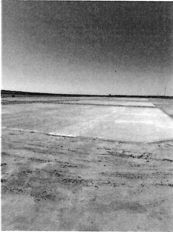
Zdjęcie nr 1. Plac składowy nr 1 (widok od strony wschodniej)
